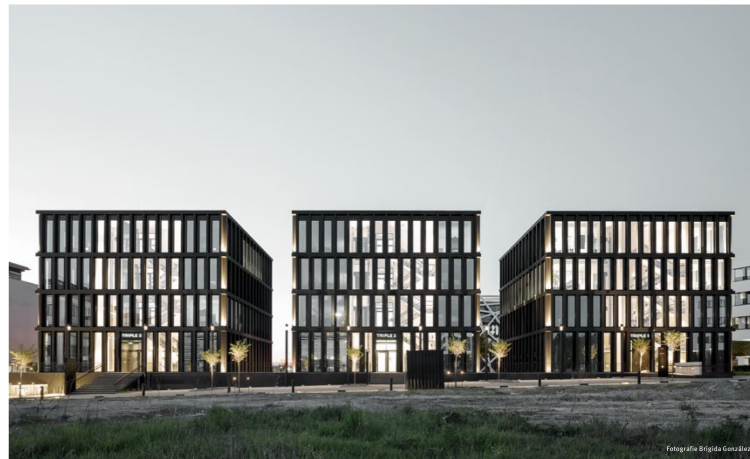
La hauteur du point lumineux est toujours la même – quelle que soit la forme du terrain. L'éclairage intérieur et extérieur a été coordonné de façon cohérente, en parfaite unité.
