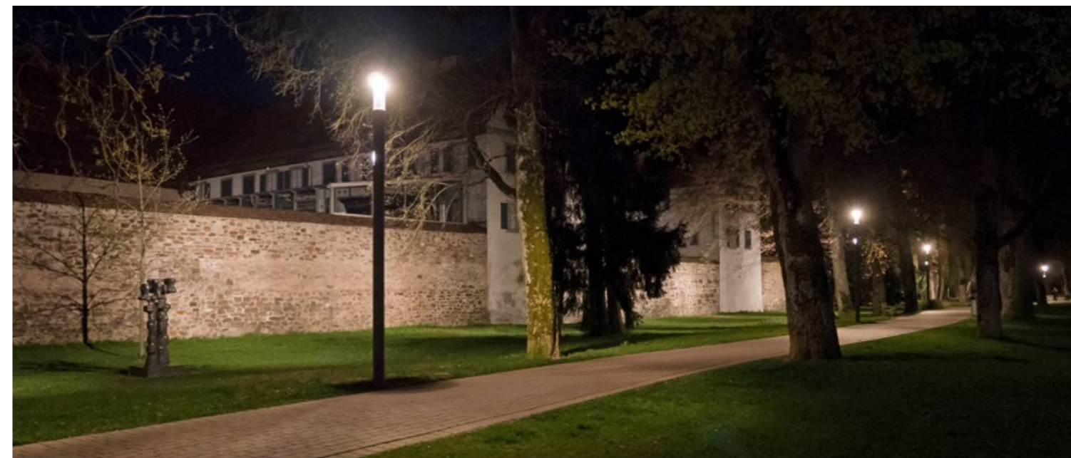
Die zielgerichtete Anstrahlung des historischen Bauwerks erfolgt aus zwei Zwischenelementen, während das Abschlusselement der CITY ELEMENTS die homogene Ausleuchtung des Geh- und Radweges übernimmt.
