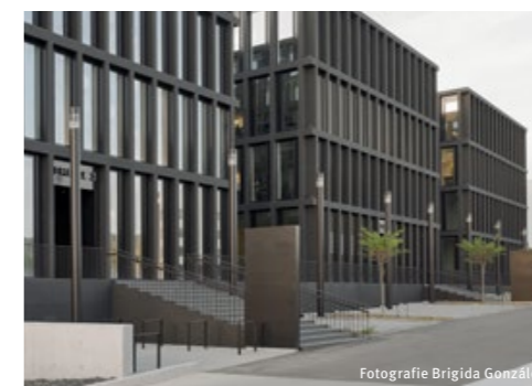
„Triple“ in Heilbronn: Die Farbe der CITY ELEMENTS von Hess wurde exakt der Farbe des Gebäudes nachempfunden – für ein harmonisches Gesamtbild.
