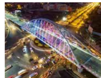
Haiphong (VN): Eine Brücke für einen sicheren Verkehrsfluss
